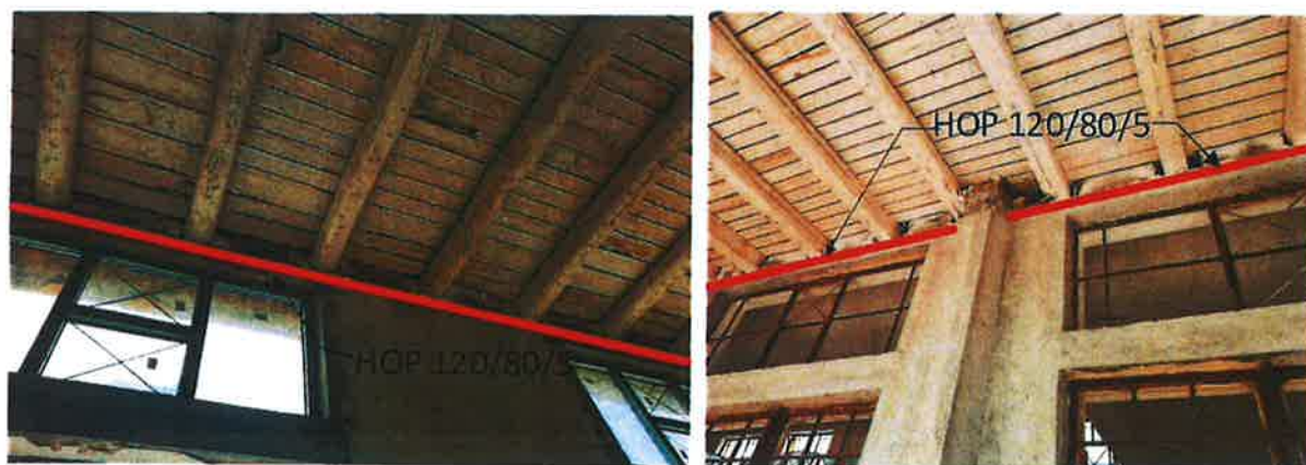
Слика 10 – НОР профил веће дужине (лево) и из сегмената (десно), за везу дрвених греда са АБ конструкцијом
