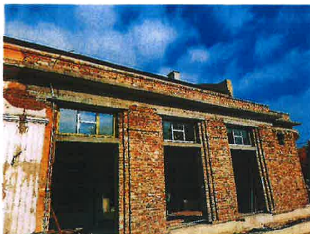
Слика 1 – део објекта који је урушен, а потом поново озидан
